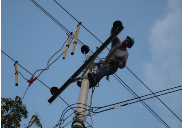
Fotografía 5 : Rehabilitación de la línea eléctrica de la planta de agua cruda san Rafael, planta Atahualpa, mantenimiento preventivo de grupos de bombeo, punta carnero, estación colonche, incluye suministro de repuestos y puesta en marcha
