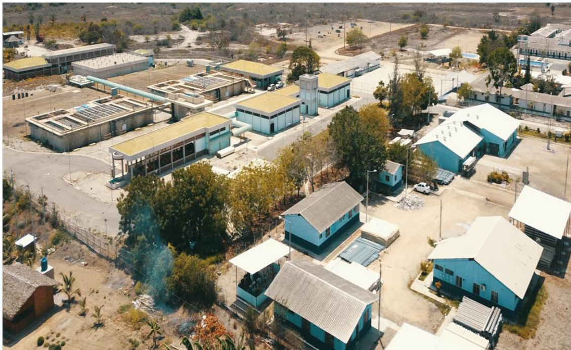
Fotografía 8 Planta Potabilizadora de Agua Atahualpa
