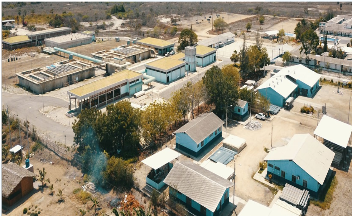
Fotografía 8 Planta Potabilizadora de Agua Atahualpa
